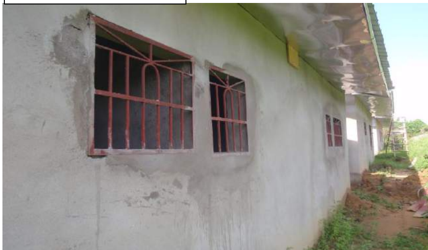
Vue arrière des bâtiments Back view of buildings
